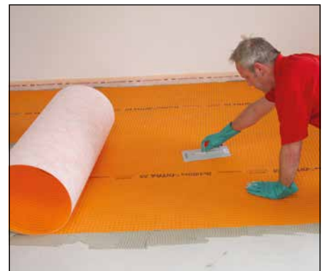
12 Einlegen und Andrücken der Schlüter®-DITRA 25. Die Verlegung erfolgt Stoß an Stoß.
