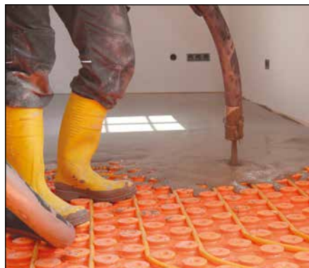
5 Einbringen des selbstverlaufenden Fließ-Estrichs: Mindestschichtdicke 8 mm über bzw. 32 mm zwischen den Noppen.
