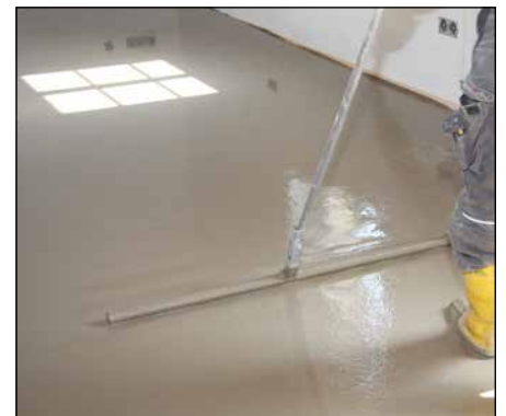
6 Durch Schwabbeln werden die Verlaufeigenschaften des Estrichs zusätzlich unterstützt.
