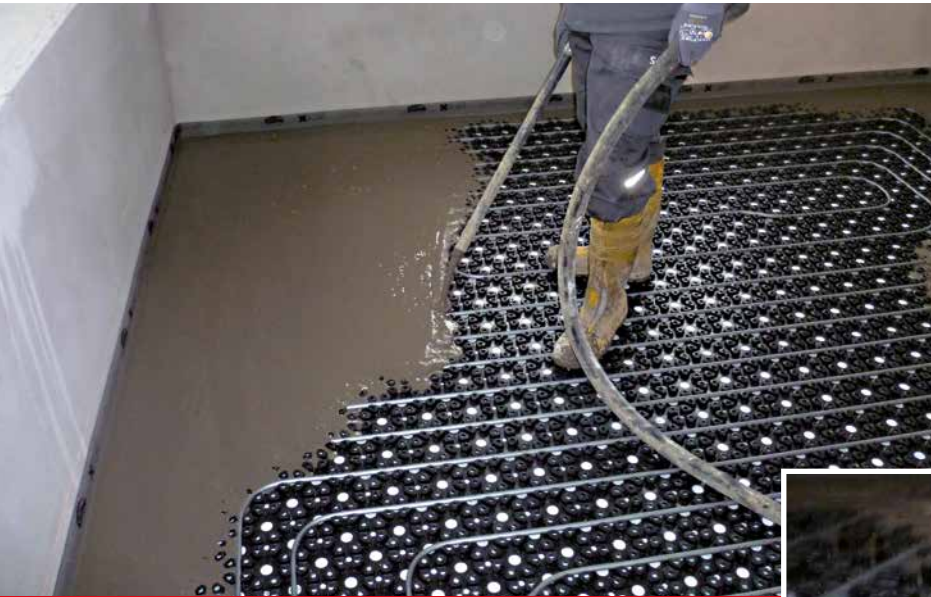
Einbau des Sopro Fließspachtel FS 15 plus 550 mit einer Pumpe.
