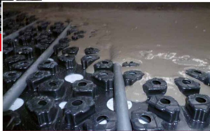
Der Sopro Fließspachtel FS 15 plus 550 fließt in das Kermi x-net C15 Dünnschichtsystem ein.
