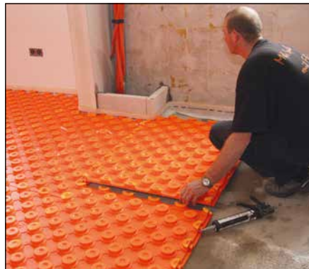
2 Einfache Verlegung der Noppenplatten Schlüter®-BEKOTEC-EN/PF durch Nut- und Feder-System.
