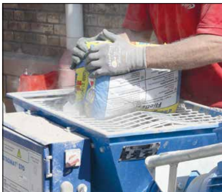
4 Verarbeitung von Sopro Rapidur® Fließ-Estrich mittels Pumpe oder von Hand möglich.
