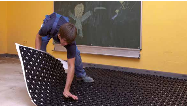
Verlegung des Kermi x-net C15 Dünnschichtsystems. Quelle: Kermi GmbH
