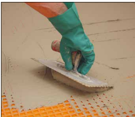
13 Zuziehen der DITRA-Oberfläche mit DITRA-X1 made by Sopro bzw. Sopro VarioFlex® Silver oder Sopro's No.1 Silver für verfärbungsempfindliche Naturwerksteine. Anschließend das Kammbett für die Fliesenverlegung aufziehen.
