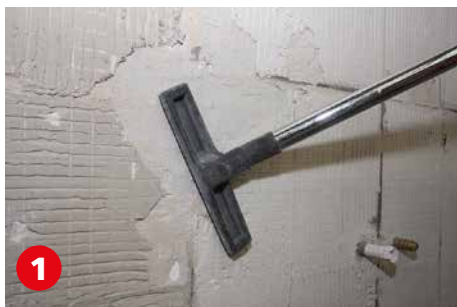
1 Reinigen des Untergrundes von losen und haftungsmindernden Bestandteilen.
