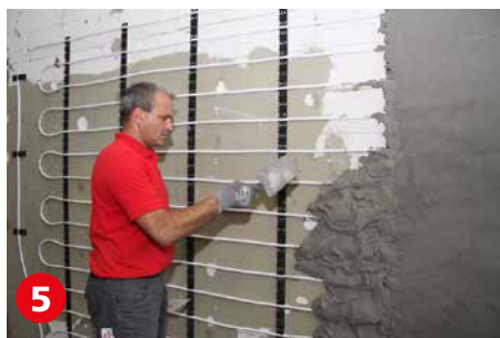
5 Händisches Verputzen der Kermi x-net C21 Wandheizung mit Sopro RAP 2 Renovier- & Ausgleichsputz 434.
