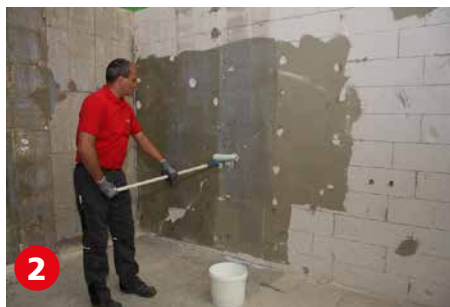
2 Grundieren der saugenden Untergründe mit Sopro Grundierung GD749.
