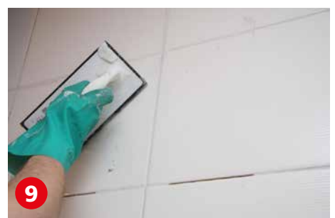
9 Verfugen der Wandflächen mit Sopro Fugenmörteln.
