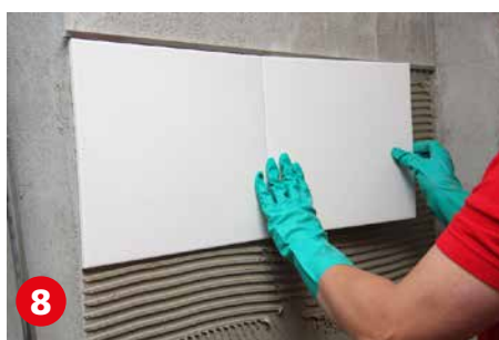
8 Verkleben der Fliesen mit Sopro Flexklebern.
