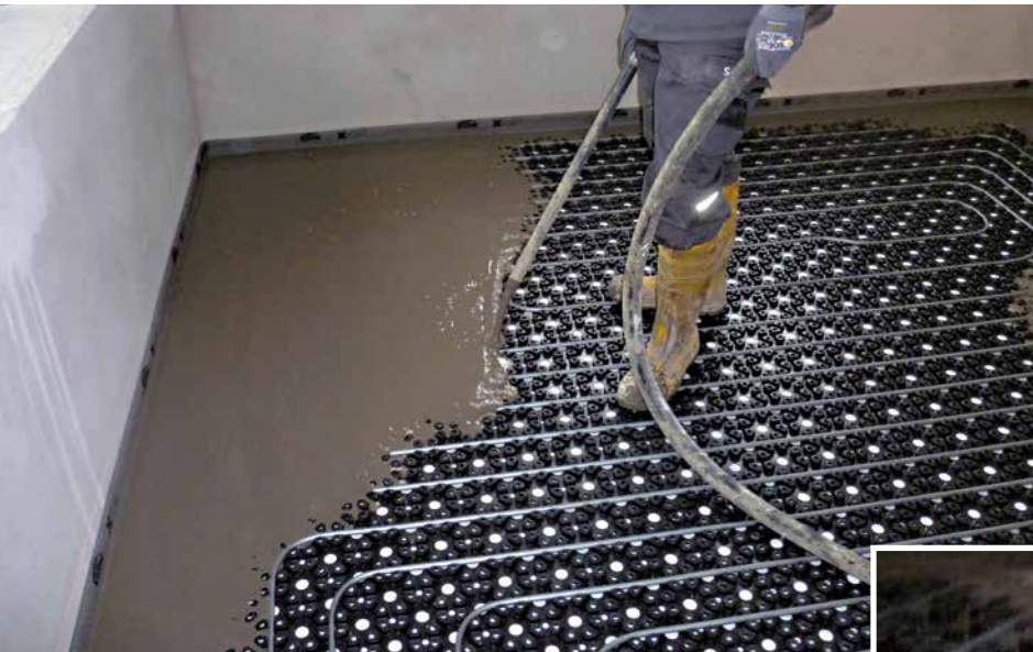
Einbau des Sopro FaserFließspachtel FAS 551 mit einer Pumpe.
