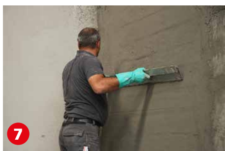
7 Lot- und fluchtrechtes Abziehen des Putzes.
