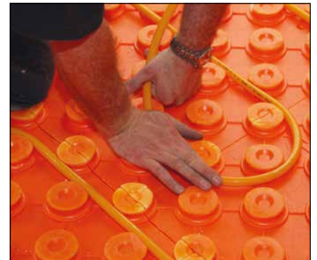
3 Einbringen der Heizrohre (Umlenkungen müssen um mind. 2 Noppen erfolgen).
