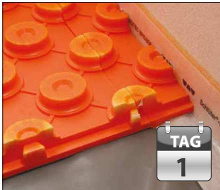
1 Randstreifen mit Klebefuß, um ein Hinterlaufen des Fließestrichs zu vermeiden.
