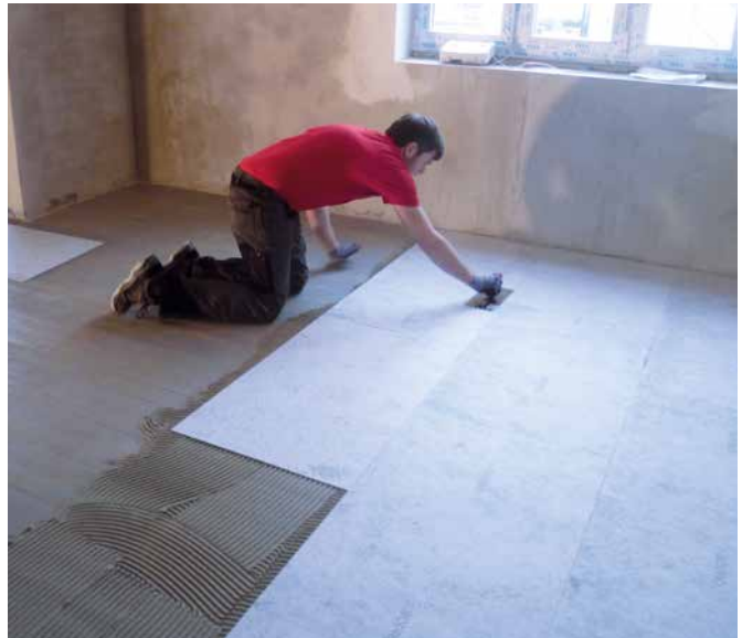
Verklebung der Sopro FliesenDämmplatte FDP 558 mit Sopro's No. 1.
