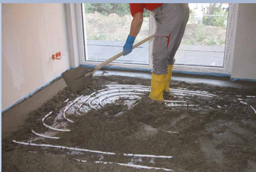
Estrichbau – Sopro Rapidur® Estriche können deutlich früher beheizt werden als ein normaler Estrich.
