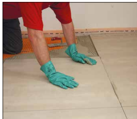
14 Einlegen der Fliesen in das vorbereitete Kleberbett.
