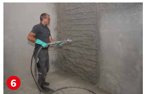
6 Maschinelles Verputzen der Kermi x-net C21 Wandheizung mit Sopro RAP 2 Renovier- & Ausgleichsputz 434.
