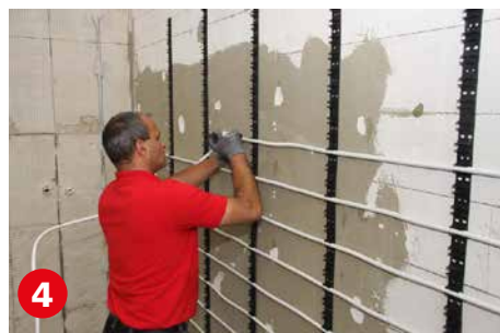
4 Einbau der Kermi x-net MKV-Verbundrohre.
