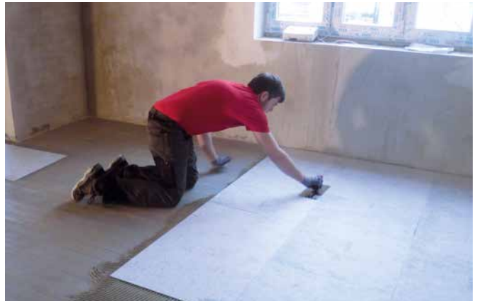
Verklebung der Sopro FliesenDämmplatte FDP 558 mit Sopro's No.1.
