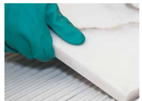
Verlegung mit Reaktionsharz
