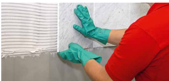
Ansetzen im Dünnbettverfahren
