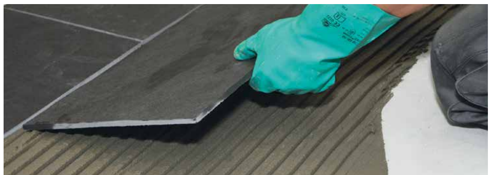
Verlegung im Fließbettverfahren
