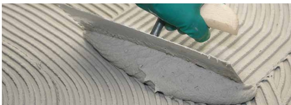
Verlegung im Dünnbettverfahren
