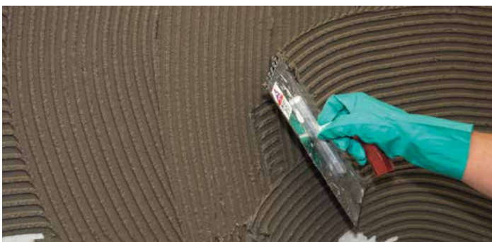
Ansetzen im Dünnbettverfahren
