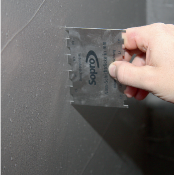
Prüfung der Nass-Schichtdicke gemäß Technischer Produktinformation.
