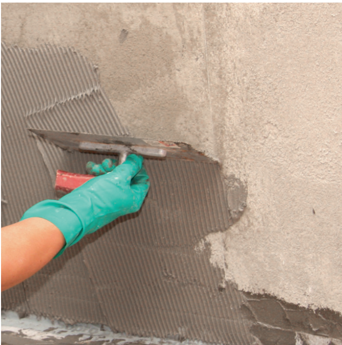
Auftrag der Abdichtung mit der Sopro TurboDichtSchlämme 2-K TDS 823 in 4 mm Zahnung.
