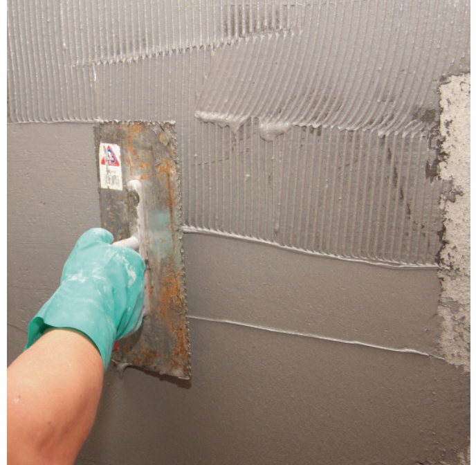
Auftrag der zweiten Schicht Sopro TurboDichtSchlämme 2-K TDS 823.
