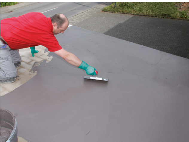
Glätten der Sopro TurboDichtSchlämme 2-K mittels Glättkelle.
