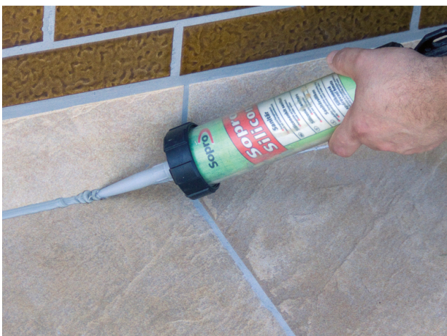
Einbringen von Sopro QuattroTec Dichtstoff matt in die Anschluss- und Bewegungsfugen.
