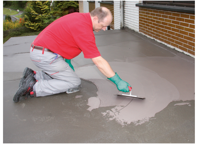
Aufbringen der 2. Schicht auf die schon nach 2 Stunden durchgetrocknete 1. Abdichtungsschicht ...
