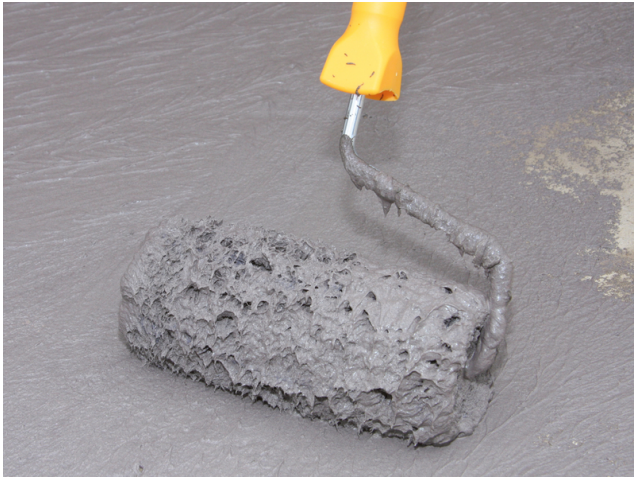
Die Verarbeitung der Sopro TurboDichtSchlämme 2-K kann auch mit einer Lammfellrolle erfolgen.
