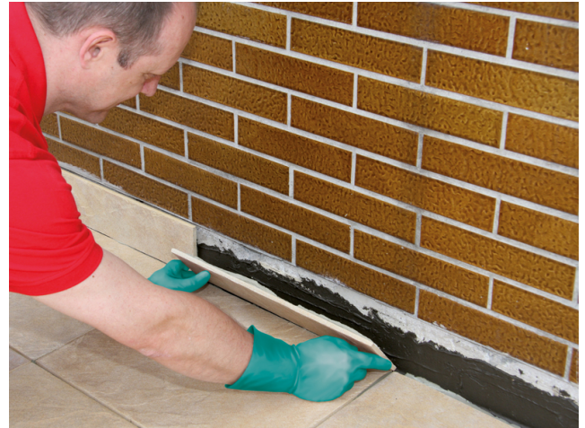
... und Ansetzen der Sockelfliese.
