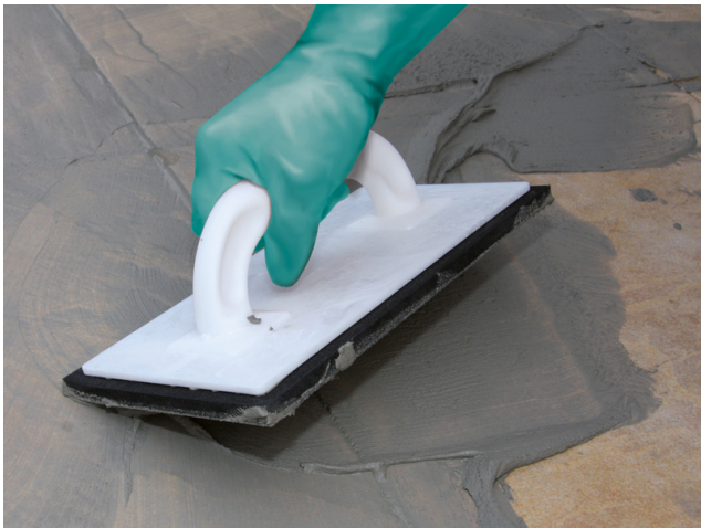
Einfügen einer Sopro Fugenmassen (z. B. Sopro FlexFuge FL) nach Erhärtung des Sopro Flexklebers
