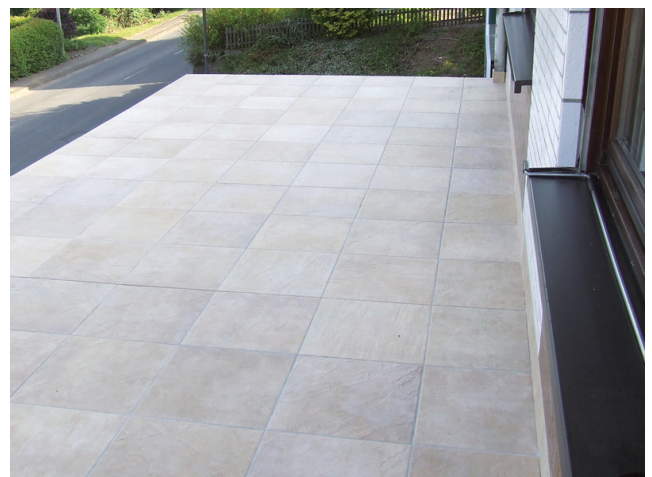
Neu verlegter Fliesenbelag auf einem Balkon mit den Sopro Systemkomponenten.
