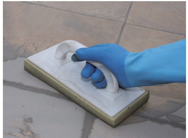
Abwaschen des Fliesenbelags nach ausreichender Standzeit der eingefügten Sopro Fugenmasse.
