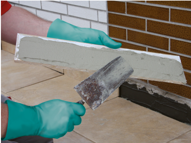
Auftragen eines Sopro Flexklebers (z. B. Sopro FKM® XL) auf die Rückseite der zurechtgeschnittenen Sockelfliese ...
