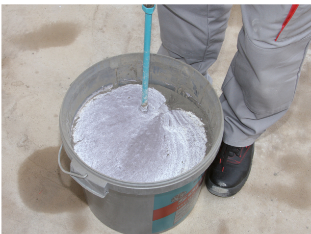
Homogenes Anmischen der zwei Komponenten ...
