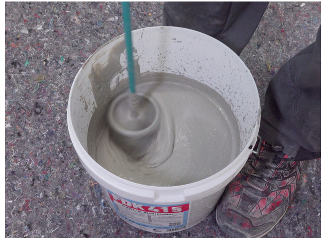
FKD 415: Flüssigkomponente vorgeben und mit Pulverkomponente maschinell anmischen. Alternativ: DSF RS im vorgegebenen Verhältnis mit Wasser anrühren.
